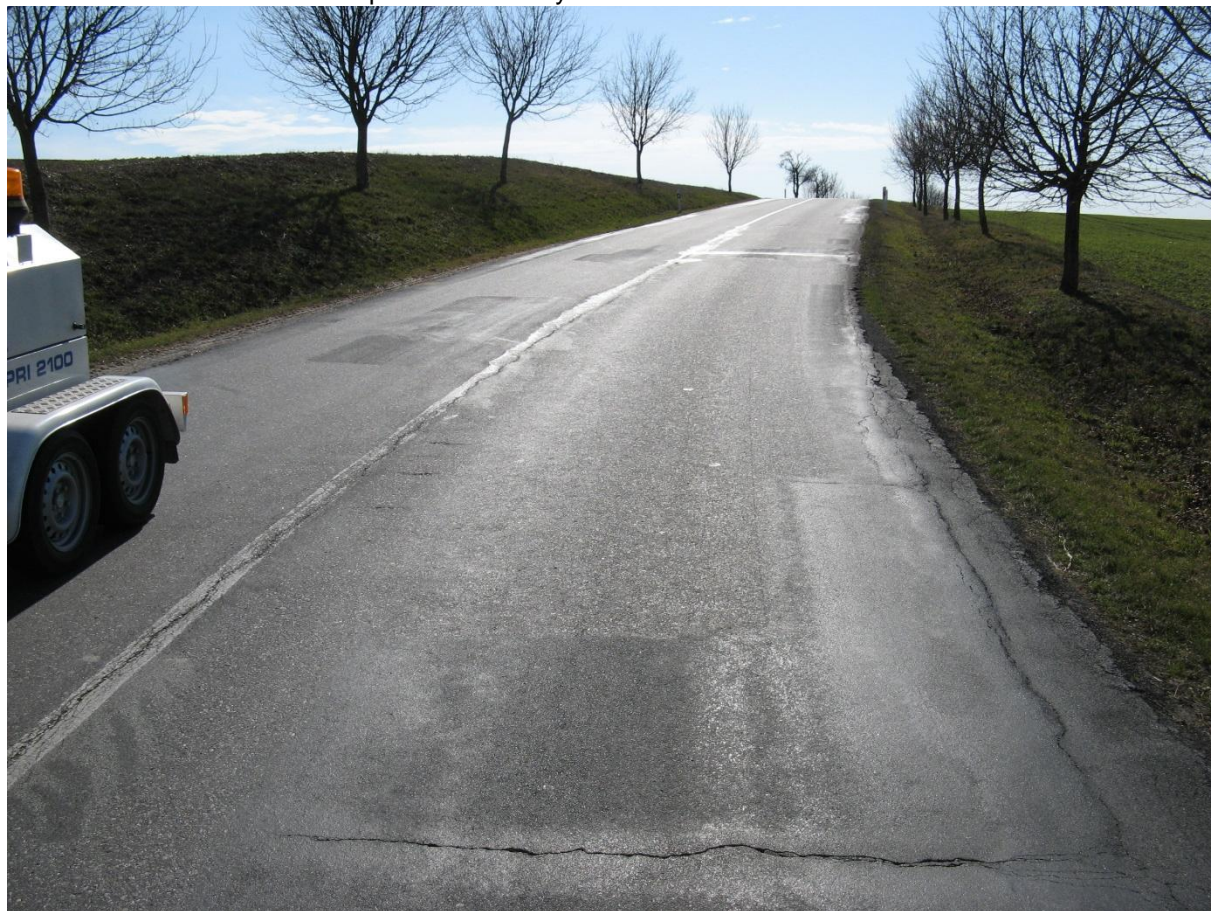
F100, km 26,100- Olamování okraje vozovky, příčné trhliny.
