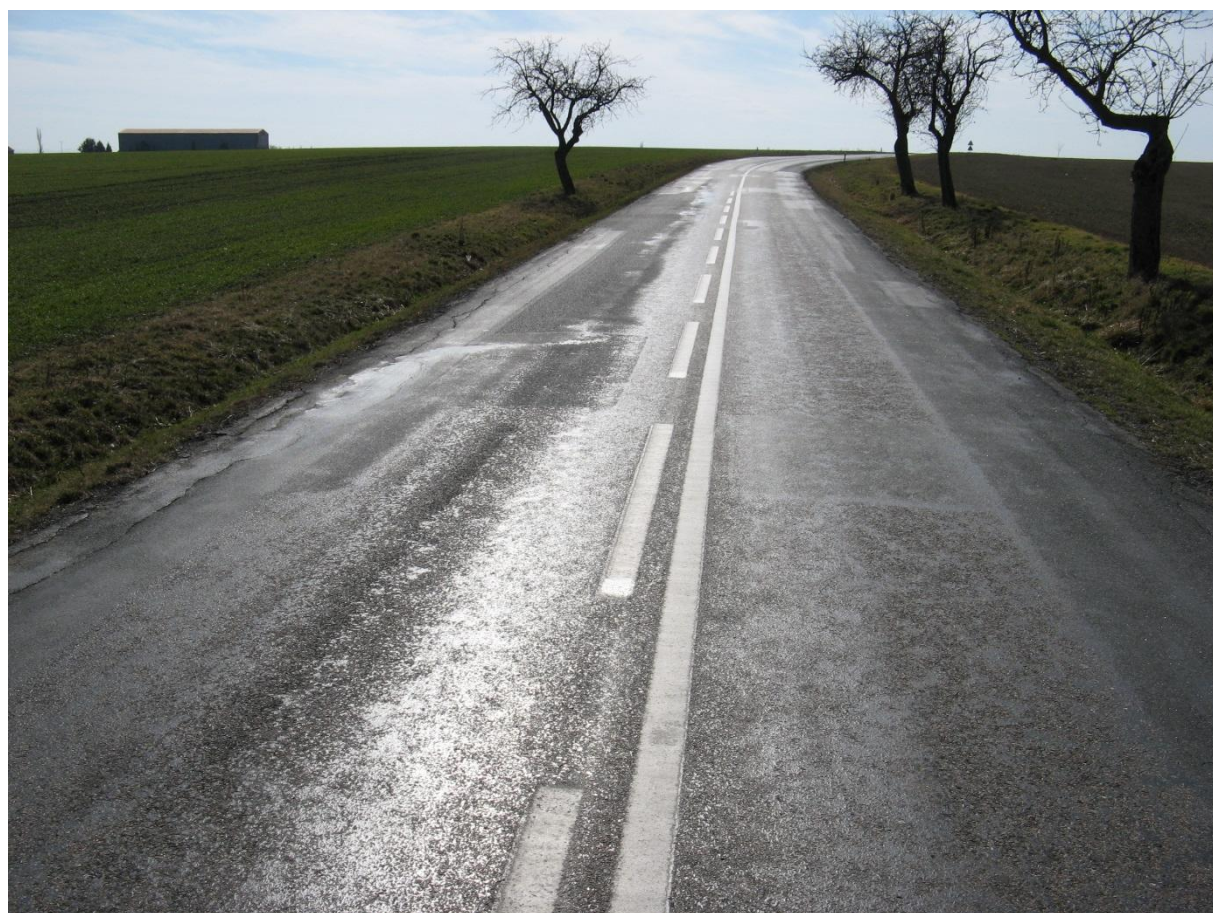
F38, km 22,900- Ztráta makrotextury a olamování okraje vozovky.
