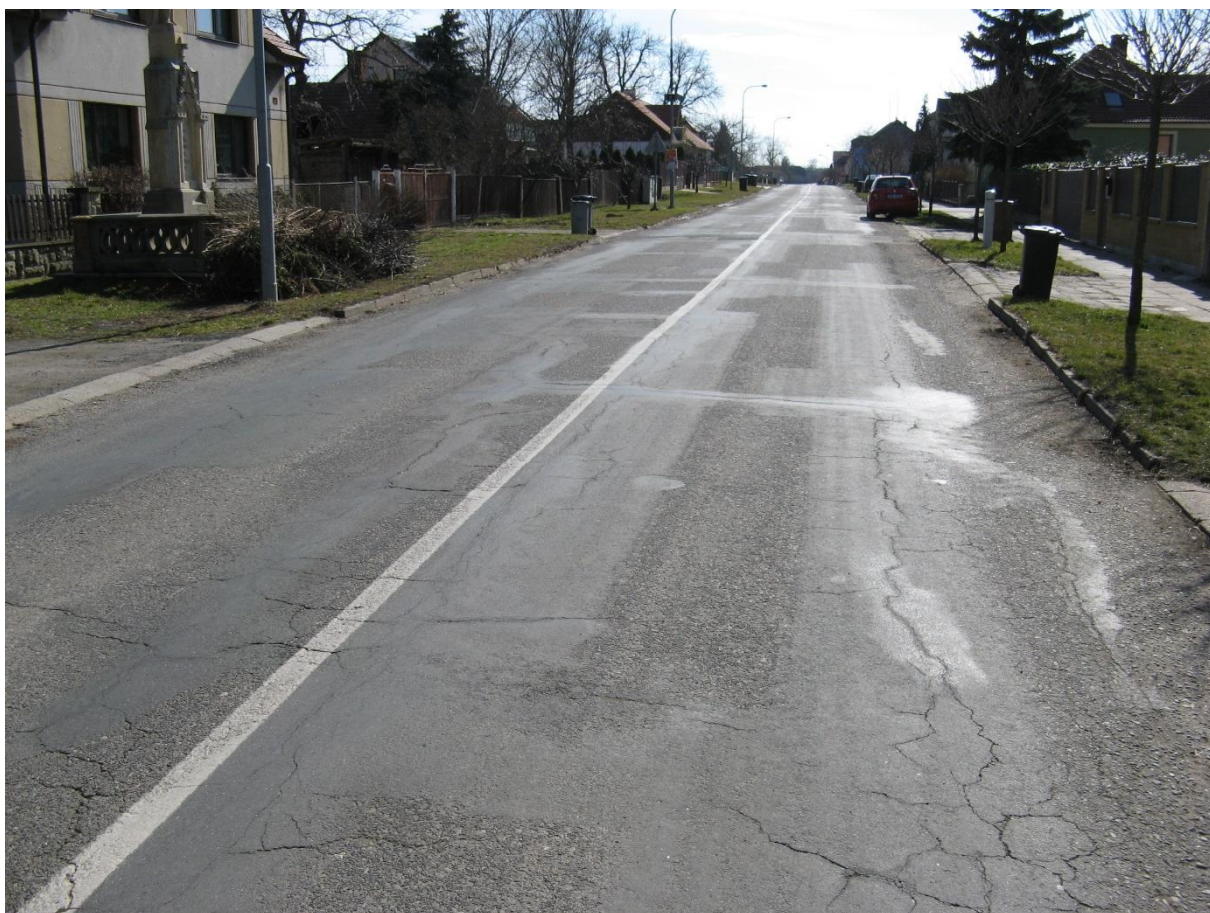
F74, km 24,800- Nepravidelné nebo mozaikové trhliny, příčné trhliny.
