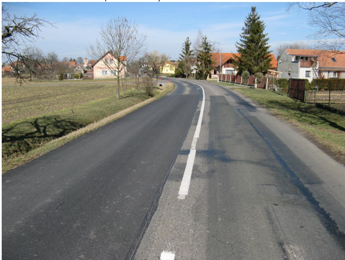
F65, km 24,210+ Vlevo oprava povrchu, vpravo vyspráva okraje vozovky.
