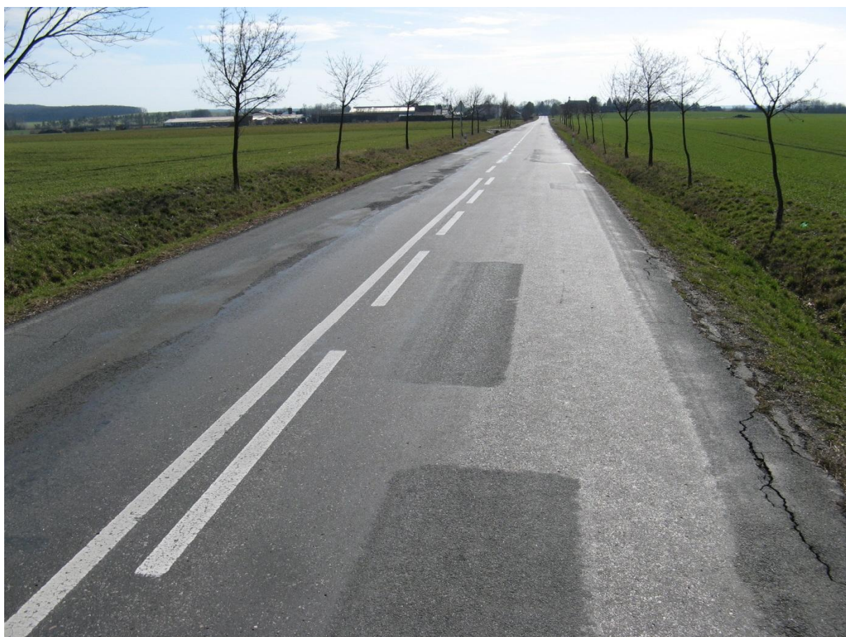
F80, km 25,800- Olamování okraje vozovky, ztráta makrotextury.
