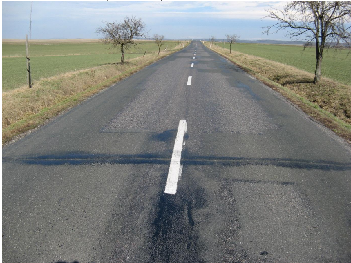
F24, km 22,210+ Příčné trhliny.
